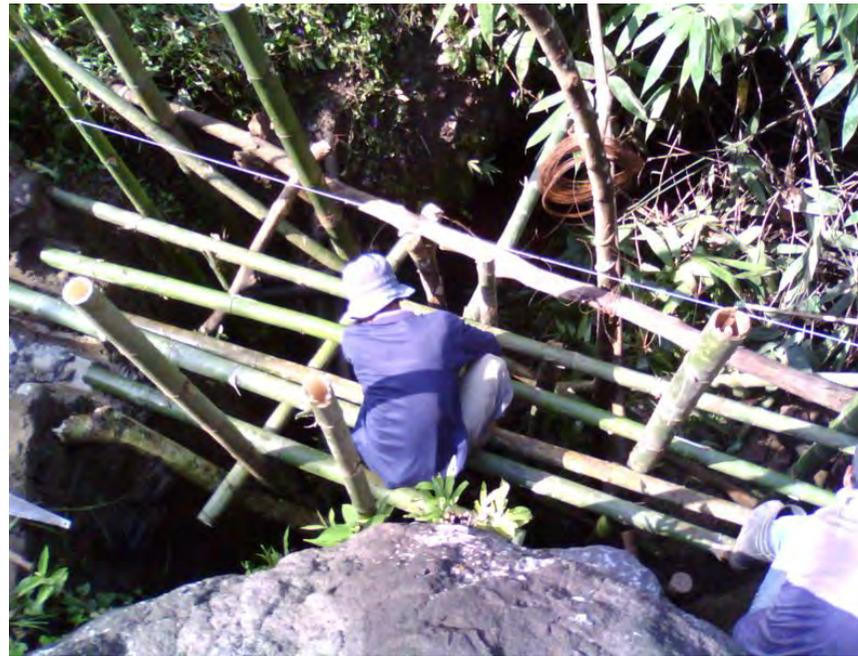
Pembuatan Jembatan Air / Talang, karena saluran melewati sistem gua batu yang tidak memungkinkan di bongkar
